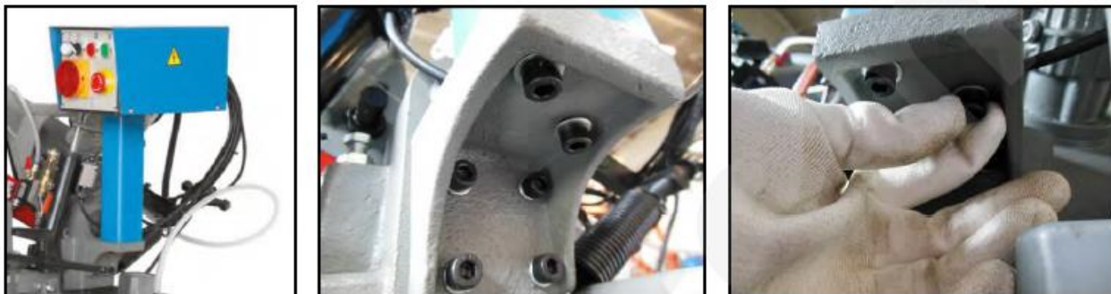
Фигура 16 – Монтаж на електрическото табло
