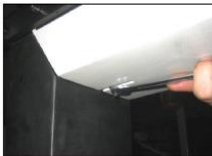
Фигура 17 – Демонтаж на контейнера
