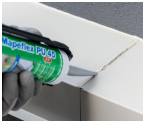
Гъвкаво уплътняване на конструктивни фуги
