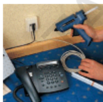
Поставяне на телефонни кабели
