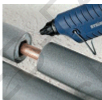
Свързване на тръби
