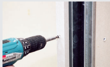
Montage der seitlichen Laibungsblenden
