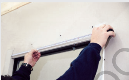
Maß nehmen für das Ablängen der Sturzblende sowie der Service- und der Passblende
