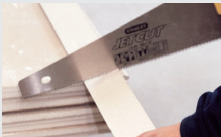
Ablängen der seitlichen Laibungsblenden
