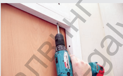
Montage der Serviceblende
