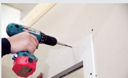
Montage der Sturzblende
