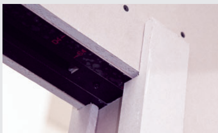
Montierte seitliche Laibungsblende mit Ausklinkung
