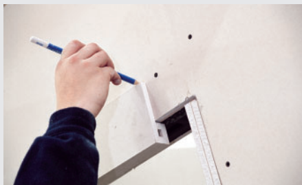
Markieren der Höhe für das Ablängen der seitlichen Laibungsblenden
