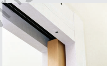
Anpassen der 2. Beplankungslage
